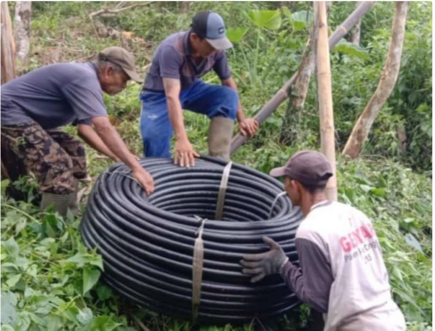
Progres pekerjaan pompa hidram pertanian Desa Panji Anom
